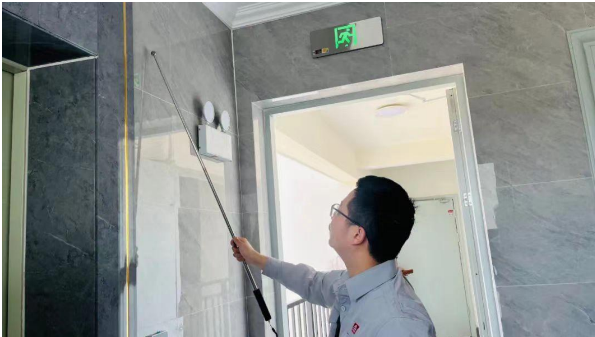
← 电梯前厅墙面全部铺装瓷砖
